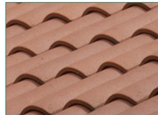
Toiture en tuiles canal, majoritairement à deux pans
