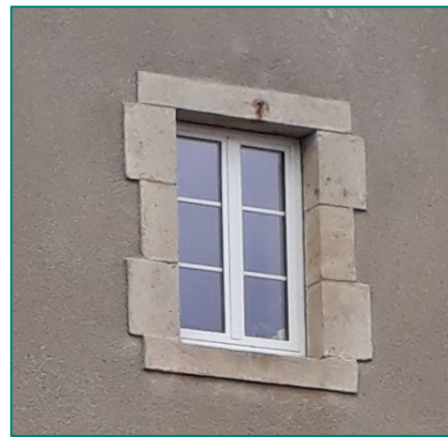
Encadrement des ouvertures en pierre de taille (parfois en brique)
